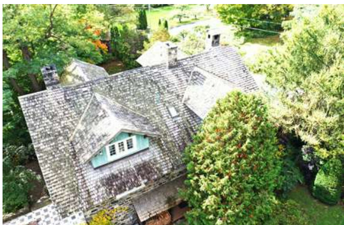
40. Vue aérienne de la toiture de la résidence Guérin montrant le revêtement de bardeau de cèdre, les quatre lucarnes, le puits de lumière et les trois cheminées.
