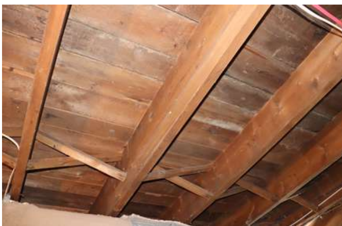
65. La structure en bois du plancher du rez-de-chaussée. La nature de ces pièces de charpente sciées laisse présager qu'elles datent de la conversion du bâtiment dans les années 1930.
