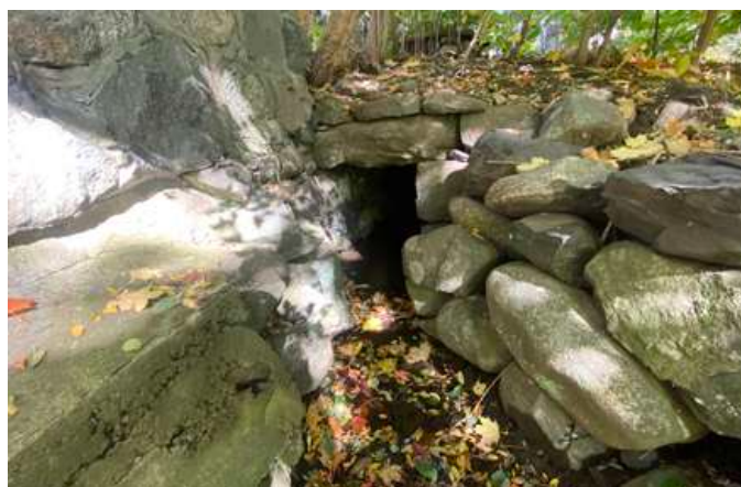
167. Vestige de l'ancien canal de fuite qui évacuait l'eau du moulin dans le ruisseau.
