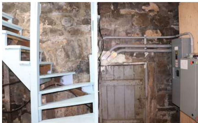
14. Ancienne ouverture du canal d'amenée dans la cave, aujourd'hui partiellement murée. Une porte donne accès à un réduit souterrain qui aurait pu servir à entreposer du charbon à une certaine époque.
