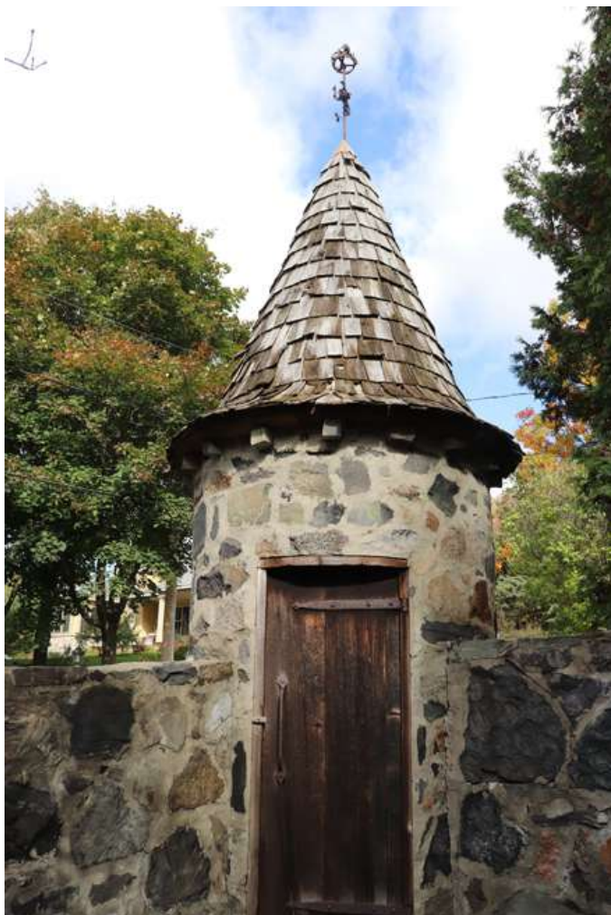
152. Détail d'une tourelle. Le toit est recouvert de bardeau de cèdre et la porte rudimentaire est en bois massif.
