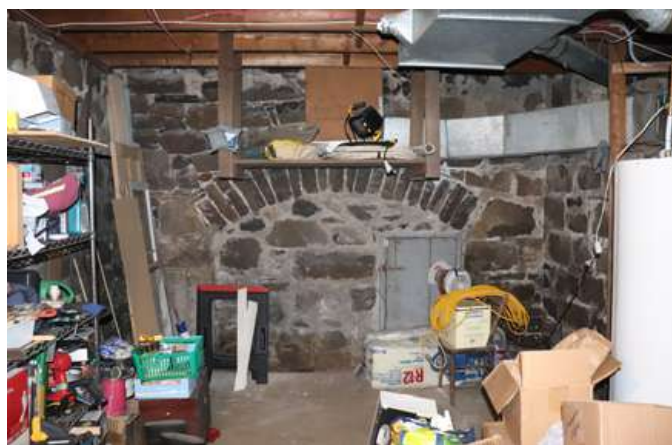
13. Ancienne ouverture du canal de fuite dans la cave, aujourd'hui murée. À l'origine, la turbine du moulin se trouvait à ce niveau en sous-sol, mais toute trace du mécanisme a disparu.
