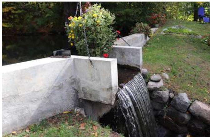
161. Le déversoir du barrage.
