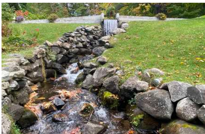
137. Le canal d'amenée assurant un débit d'eau constant.
