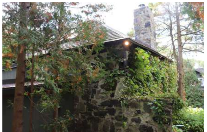
111. Vue arrière de l'ermitage comportant des murs en pierre et une toiture à croupes en bardeau de cèdre.
