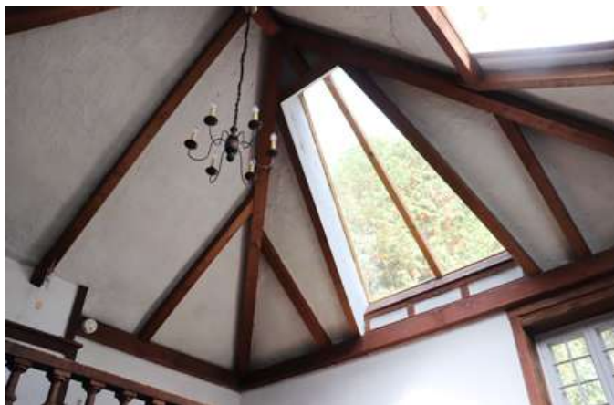
119. Le toit de la section ancienne exhibant sa structure en bois est éclairé par deux puits de lumière.
