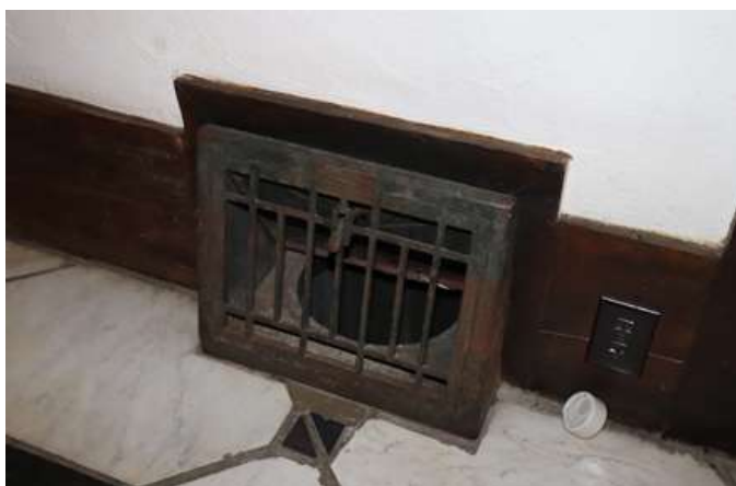
70. Détail d'une grille de chauffage au plancher du hall d'entrée.
