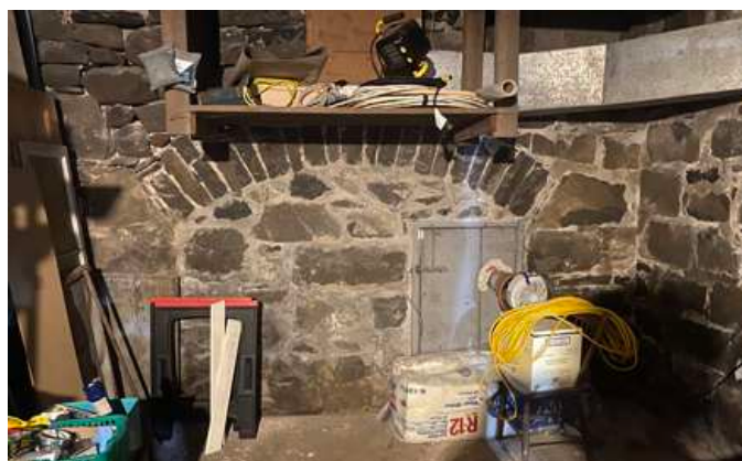
61. Ancienne ouverture du canal de fuite que l'on perçoit grâce à l'arc encore présent dans la pierre.
